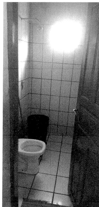
Banheiro 1 Fonte: Acervo Técnico (2021)
